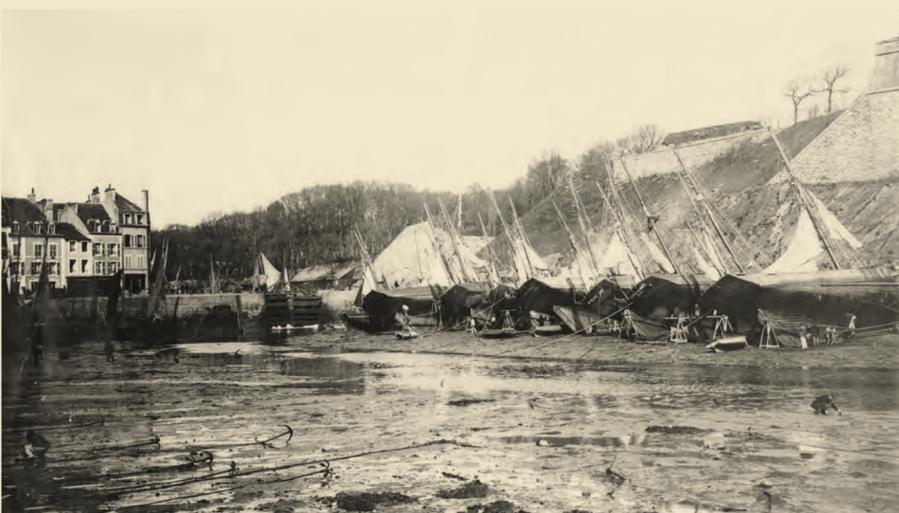
Thoniers construits à Belle-Ile pour les armateurs de l'île de Groix, en carénage sous le chemin de halage.
