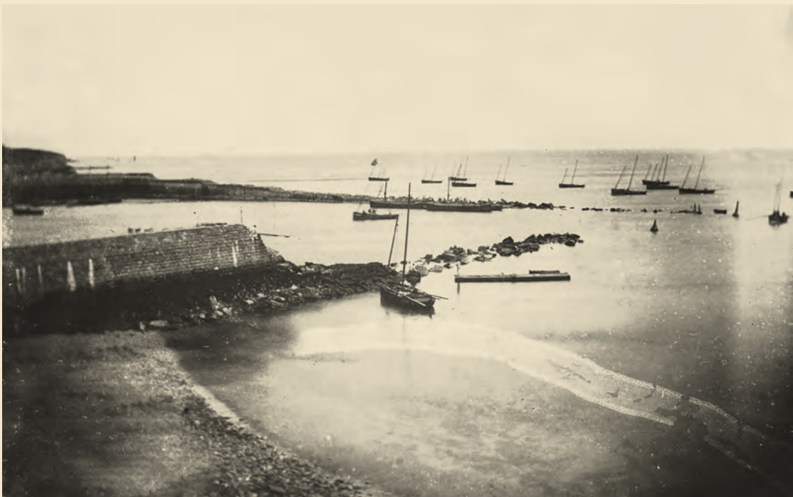
Construction des deux digues, les travaux ont duré 8 ans.
